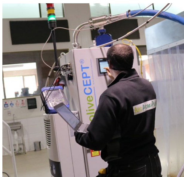
Installation av oliveCEPT® i Chile
